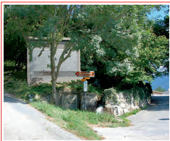
Die neue Trafostation Felsenweg (Fotomontage)
