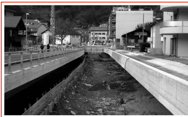
Aktueller Bauzustand Abschnitt Furkastrasse – Zentrum Kelchbach
