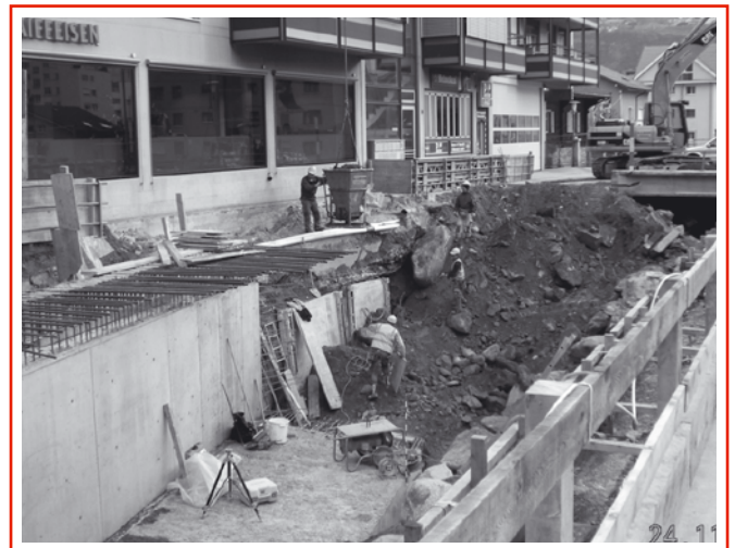
Aktuelle Arbeiten Bachverbreiterung auf der Ostseite beim Zentrum Kelchbach
