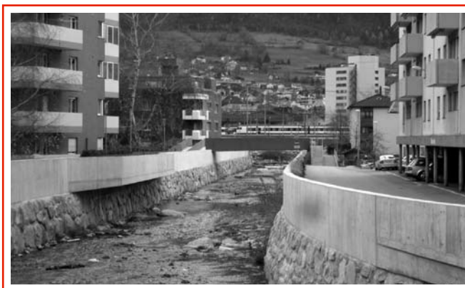
Neues Bachbett im Abschnitt Rhone – Furkastrasse
