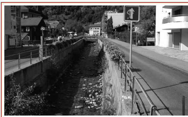
Ursprünglicher Zustand Abschnitt Furkastrasse – Zentrum Kelchbach
