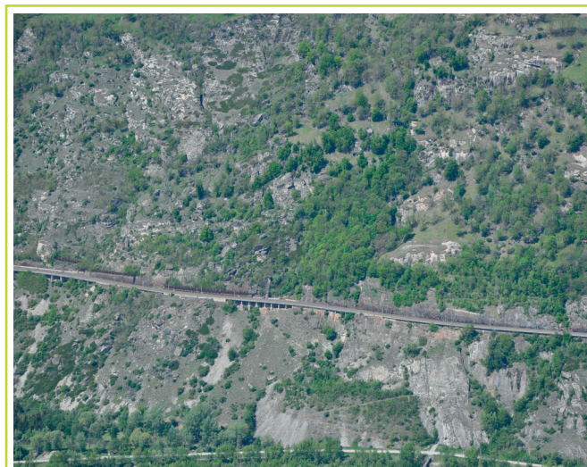
Im Frühjahr 2015 werden die Leitungen und das Gebäude für die unterste Kraftwerkstufe bei Brigerbad errichtet.
