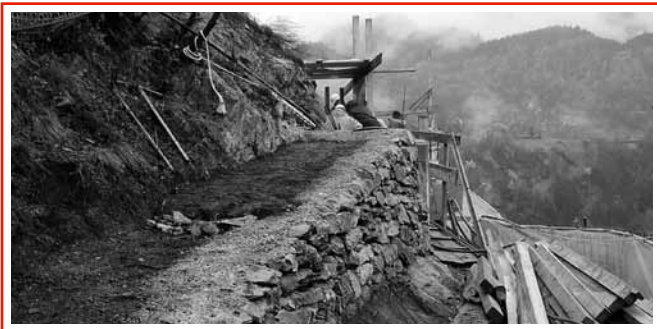
Wegarbeiten im Mittelteil
