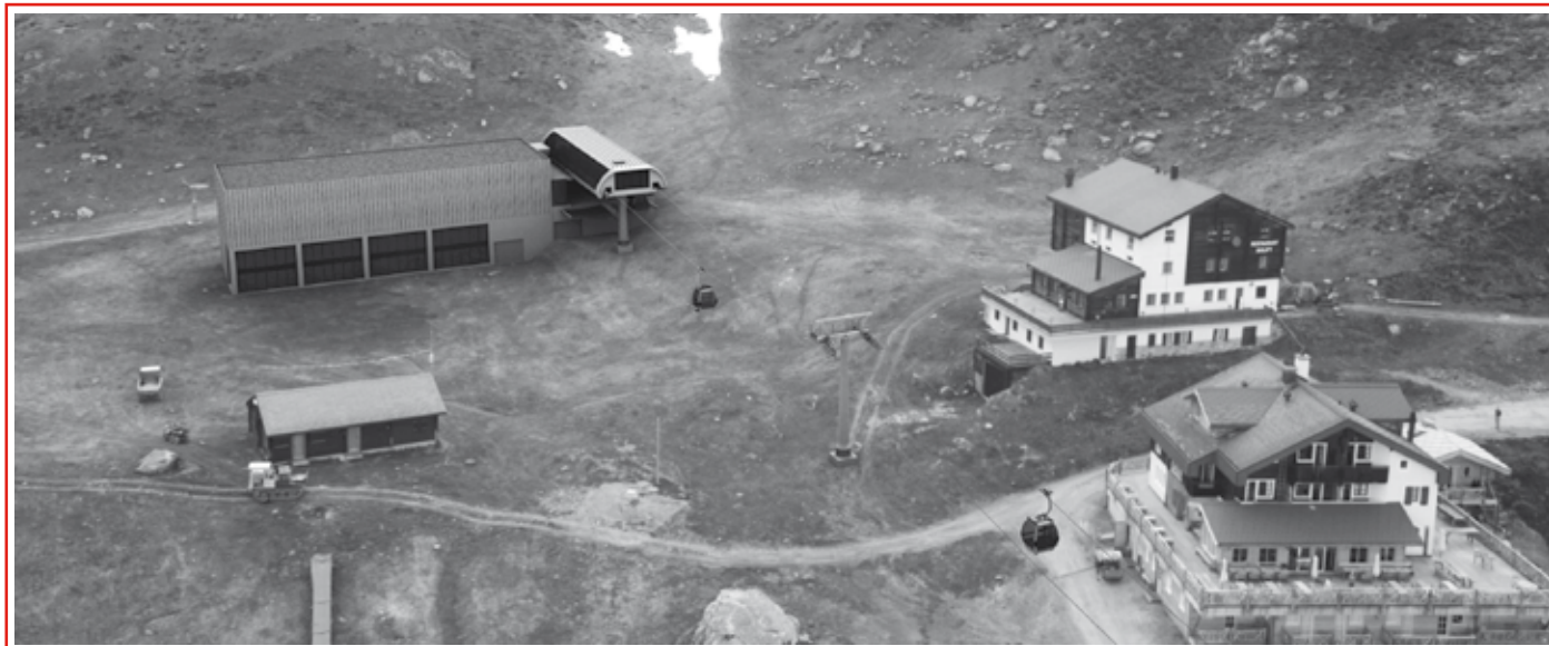
Für den Bau der neuen Gondelbahn-Bergstation ist eine Einzonung nötig. Fotomontage Garaventa AG
