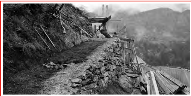
Wegarbeiten im Mittelteil
