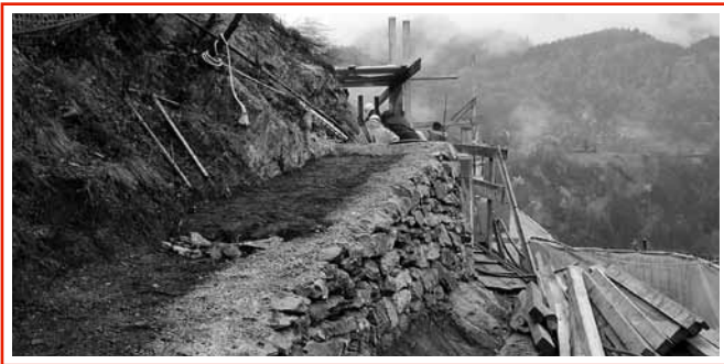
Wegarbeiten im Mittelteil
