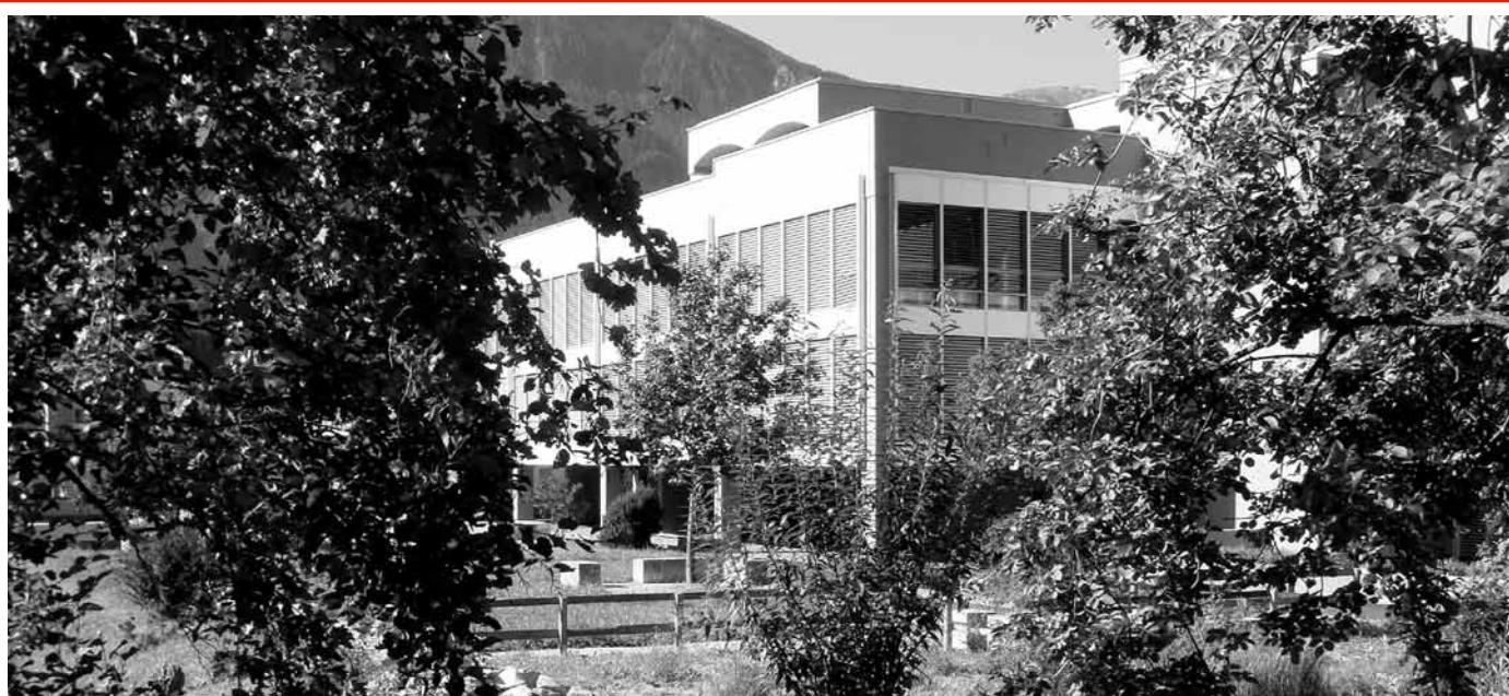
Attraktiv und modern eingerichtet – das Regionalschulhaus Bammatta heute nach der Gesamtsanierung 2009/10
