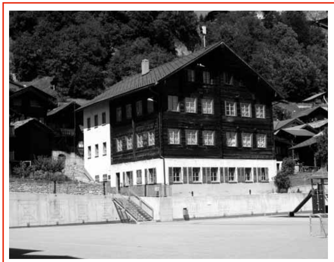
Das 100-jährige Schulhaus in Mund wird saniert.
