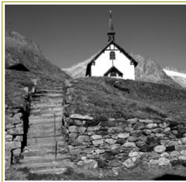
Eines der Projekte mit erster Priorität: Die Sanierung der Trockenmauern am Aletschbord.
