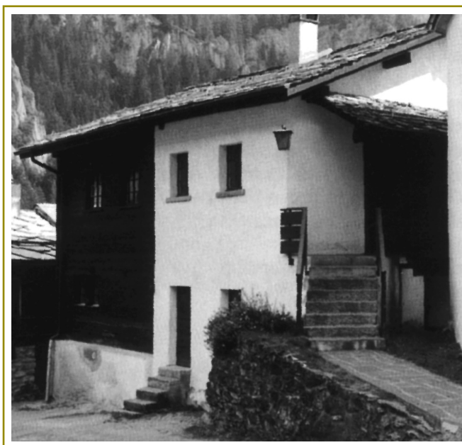
Das Ferienhaus «Schulhaus» in Blatten
